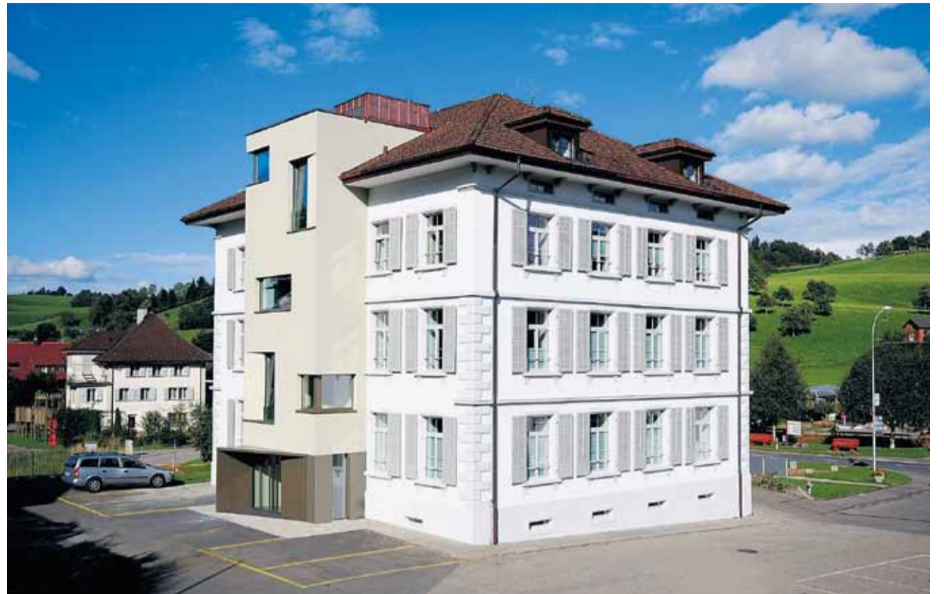
Das sanierte Gemeindehaus mit dem modernen Anbau erstrahlt in neuem Glanz.
